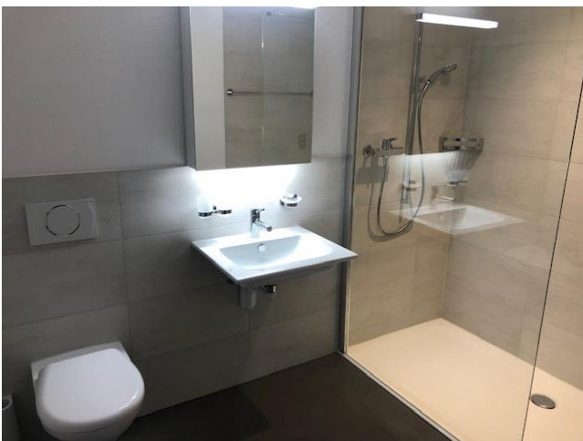
abbildung 2-wc/du platten an boden und wänden, abrieb wände
